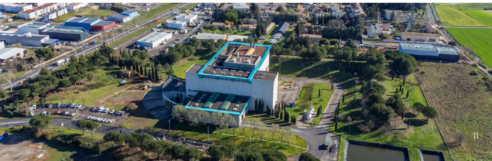
L'incinérateur de Lunel-Viel - Crédit Photo : SUEZ
