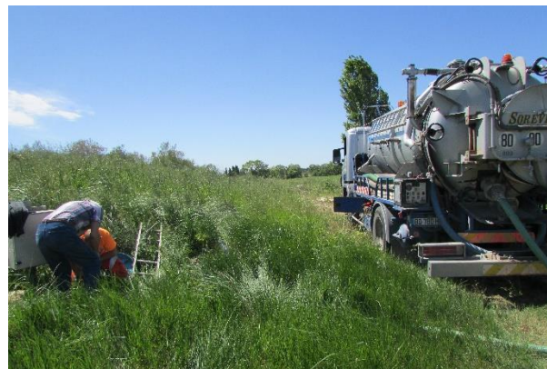
Photo prise le 28/04/16 – Curage du poste N°2
