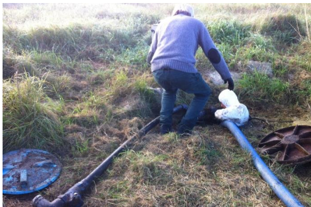
Photo prise le 17/11/15 – Remplacement pompe N°2
