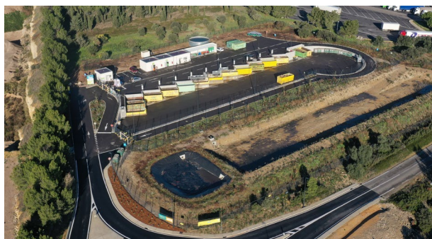
Déchèterie de Villetelle
