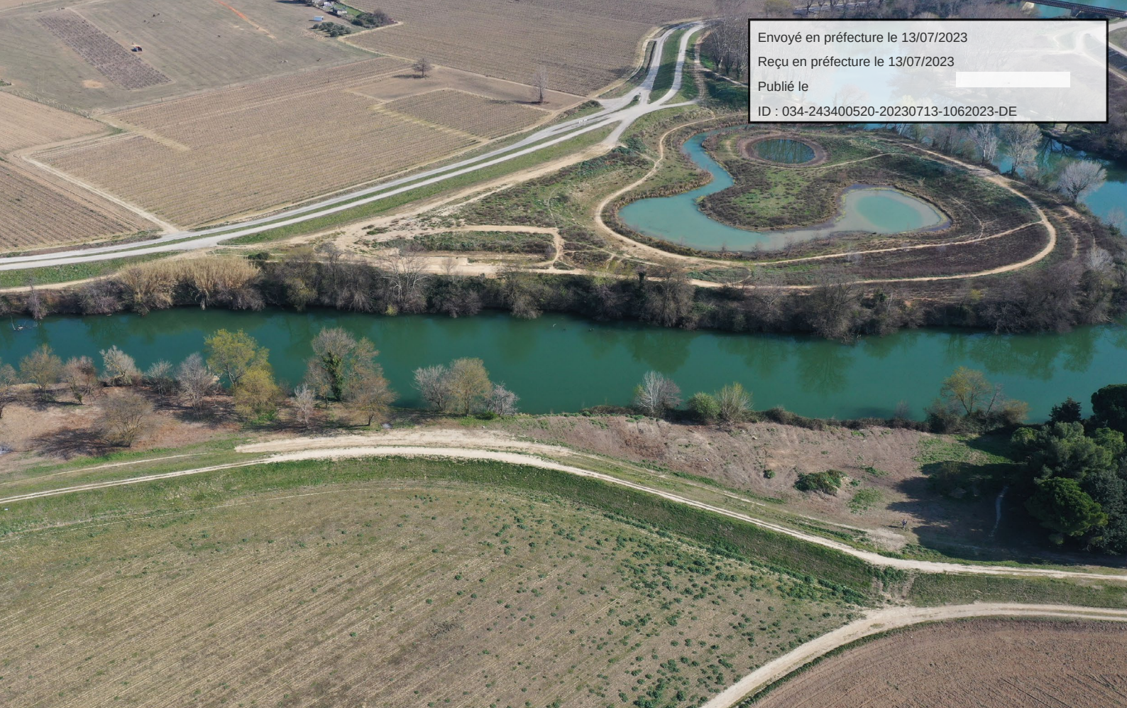
Aménagement d'une digue à Marsillargues
