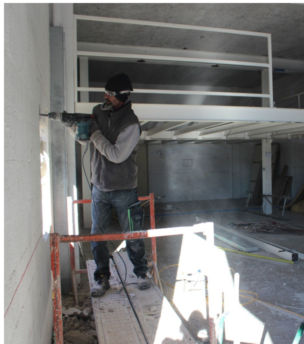
Travaux d'agrandissement du siège de la Communauté de Communes
