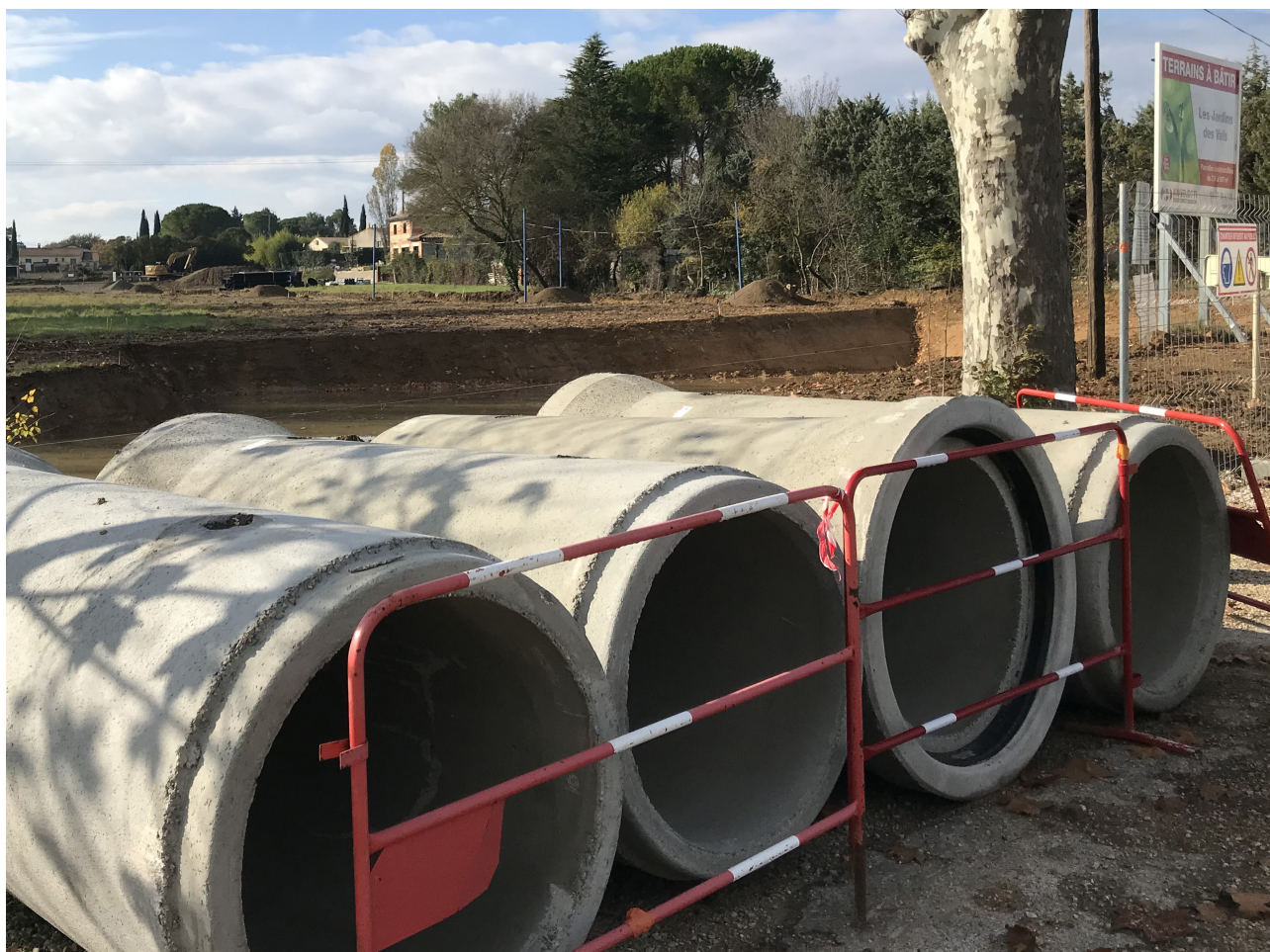
Travaux de viabilisation de l'opération du Jardin des Vals à Saussines.
