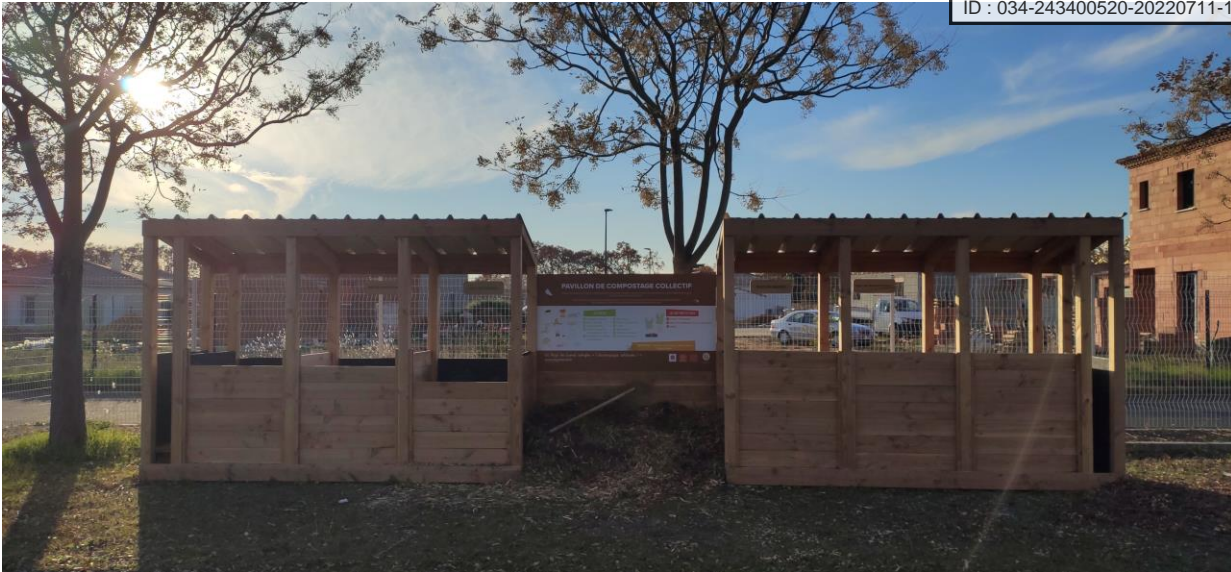
8 novembre 2021 : installation du pavillon de compostage
