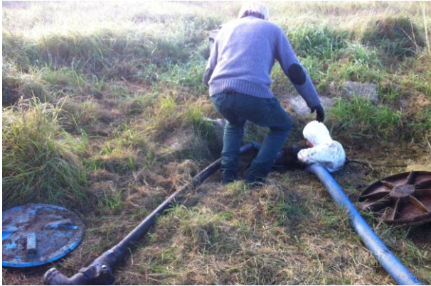
Photo prise le 17/11/15 – Remplacement pompe N°2
