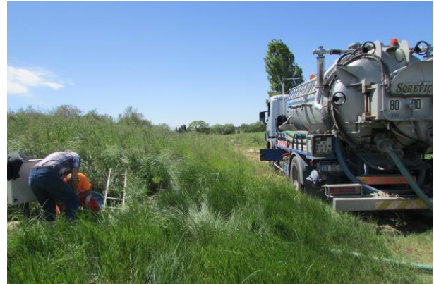
Photo prise le 28/04/16 – Curage du poste N°2
