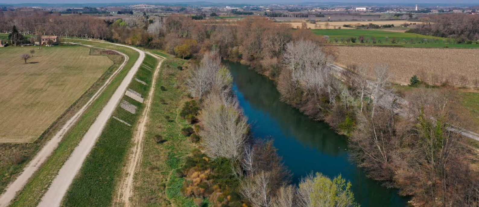
Aménagement d'une digue à Marsillargues
