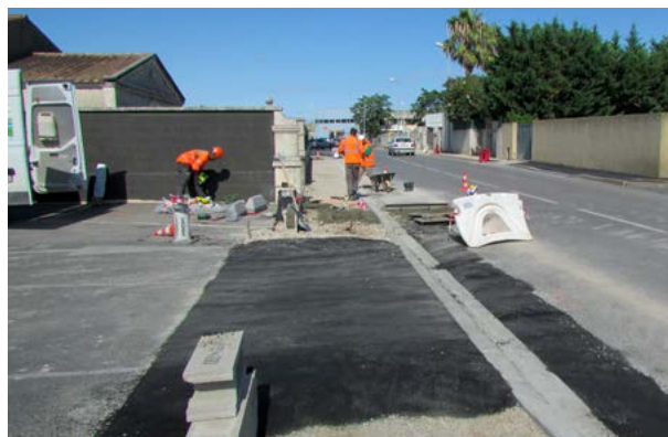
Aménagement des trottoirs rue du Levant (ZAE du Levant)
